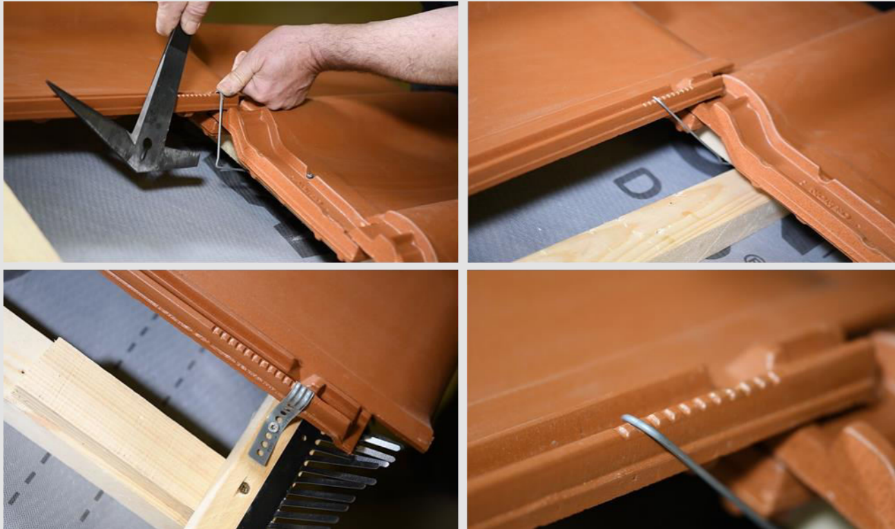
Beütős, beakasztós és az univerzális viharkapocs beépítése, továbbá beakasztós viharkapcsoknak kialakított barázdásor az oldalhornyban
